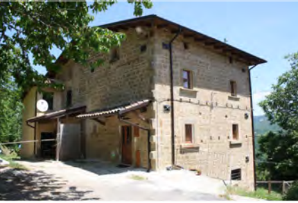
Edificato in parte riparato dai danneggiamenti
