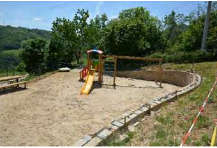
Parco pubblico attrezzato in fase di sistemazione
