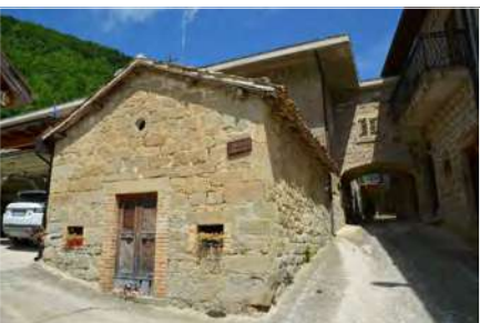
Passaggio pubblico su strada
