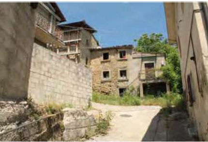
Vista piazza principale con parcheggio
