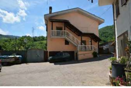
Edificato su area pubblica parzialmente riparato
