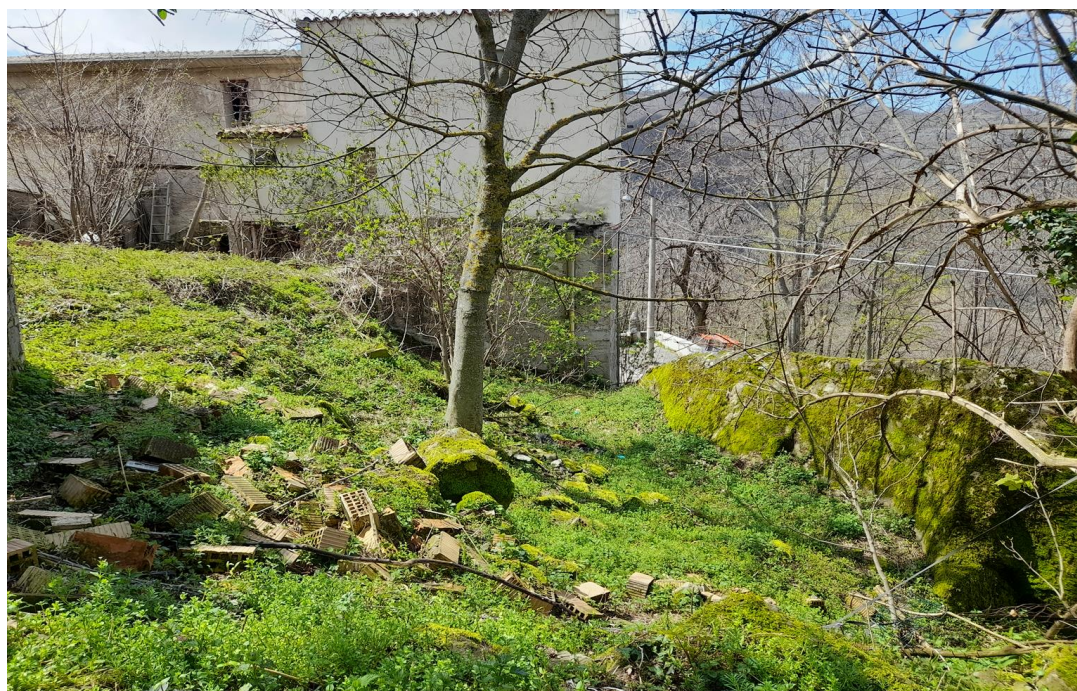
Fronte a monte
