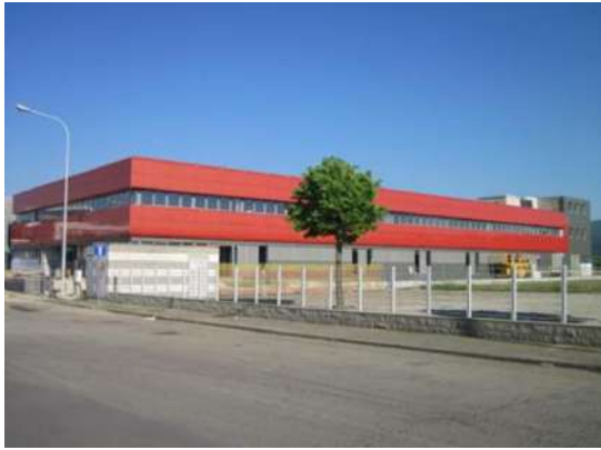
Figura 5: Immagine esterna del Datacenter
